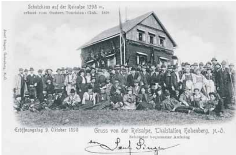
▲ Vor mehr als 100 Jahren wurde vom ÖTC das Schutzhäus auf der Reisalpe errichtet.
